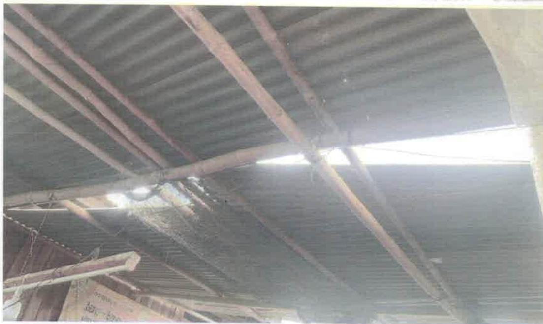
ภาพภายในอาคารที่กำลังดำเนินการก่อสร้าง
